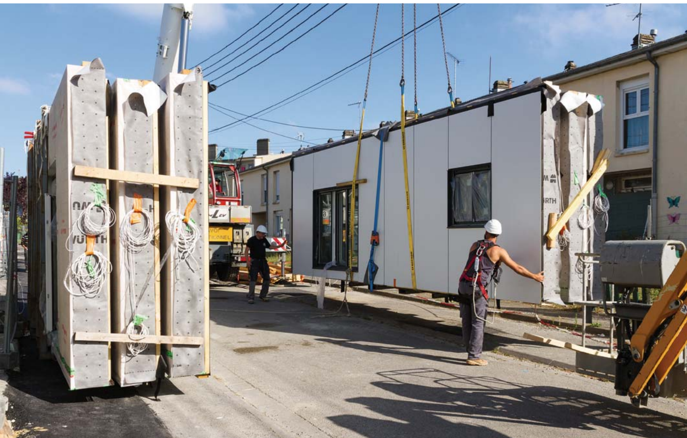
Modulare Gebäudesanierung Foto: © Fabrice Singevin
