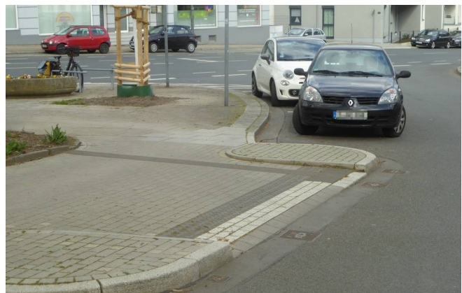
Bild 35: Gehwegvorstreckungen verhindern, dass vor und auf Querungsstellen geparkt wird.
