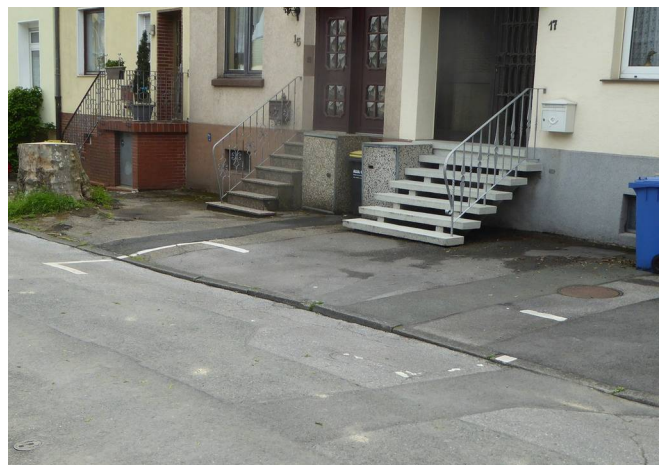
Bild 61: Wird beim Aufheben der Sonderparkfläche die Parkmarkierung gelassen, ist Gehwegparken an dieser Stelle erlaubt.
