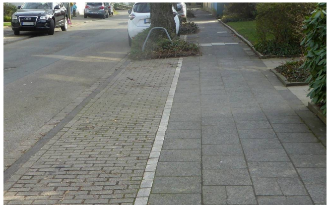
Bild 51: Gefordert ist eine kontrastierende Linie, welche die Parkfläche begrenzt.
