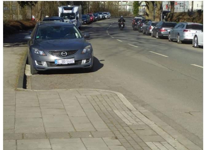
Bild 46: Gehwegvorstreckungen verdeutlichen die Lage der Fahrgasse.
