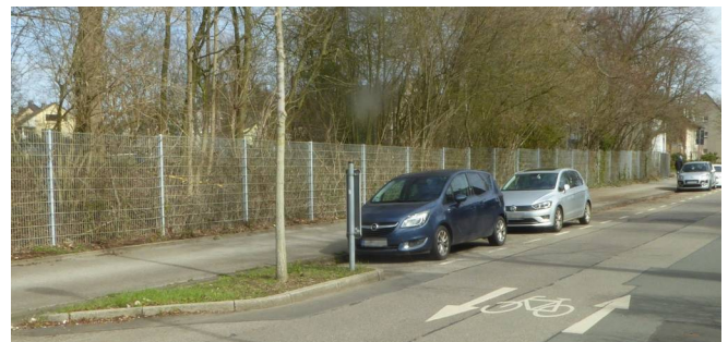
Bild 47: In die Fahrbahn gebaute Baumbestecke sorgen für Stadtgrün und korrektes Parken.
